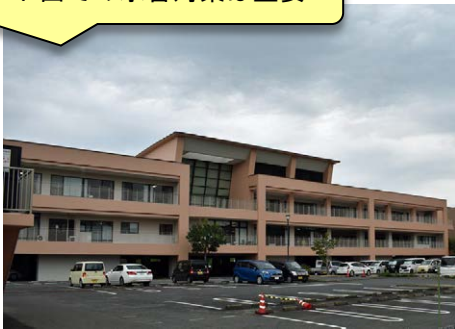
水害対策として施設1階はピロティで入所者はいません
