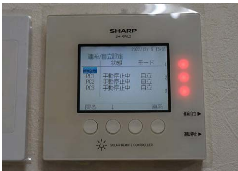
太陽光発電システムで停電時に使用できる自立運転モードへの切替
