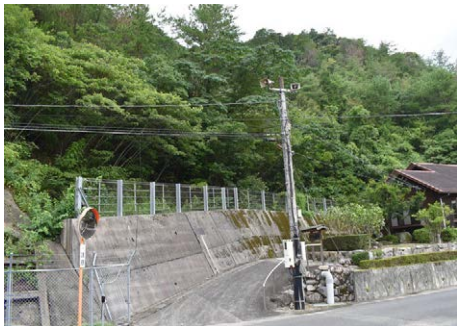
崩壊の危険がある急傾斜地は対策工事を実施している
