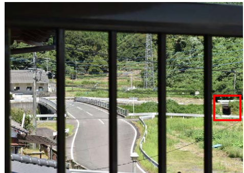
施設2階から見える水路の穴
