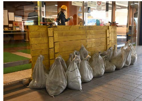
玄関に防水板を設置
