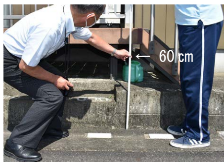
浸水想定区域に立地しているが、施設1階の床面は地面から約60cm高い
